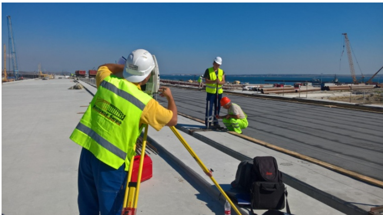
Рис. 5. Контроль высотного положения копирной струны
