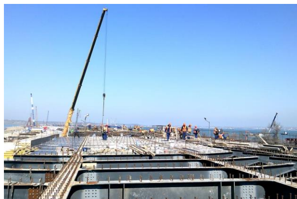
Опоры №183, п.с.12/2 (а/д мост). Устройство сталежелезобетонного пролетного строения 04.2017
