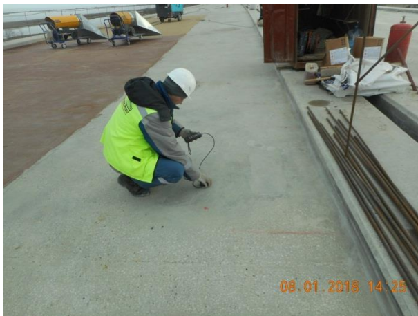
Пролётное строение в осях опор №131- №135(а/д мост). Инспекционный контроль влажности поверхности бетона плиты проезжей части, в осях главных балок 3-4, перед устройством праймера МАТАКРИЛ. 01.2018
