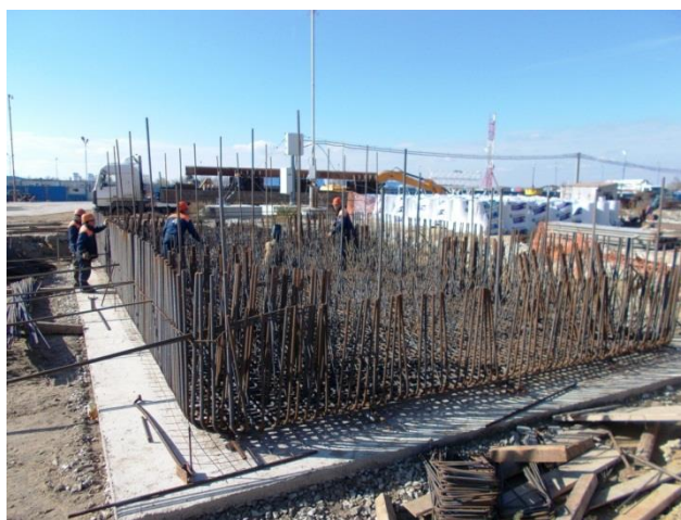
Опора № 180 (ж/д мост). Устройство арматурного каркаса ростверка. 11.2017
