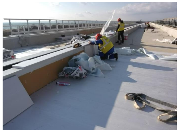
ПС в осях опор 168-169 ось А-Б (ж/д мост). Устройство защитного слоя гидроизоляции. Укладка плит из пенополистирола. 03.2019
