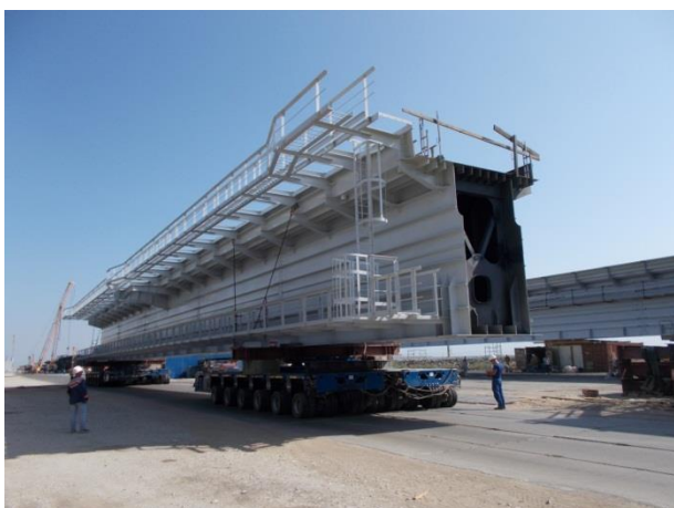
Пролётное строение в осях опор № 100-101 (ж/д мост). Транспортировка и поперечная подвижка металлического пролетного строения в осях В-Г. 09.2018
