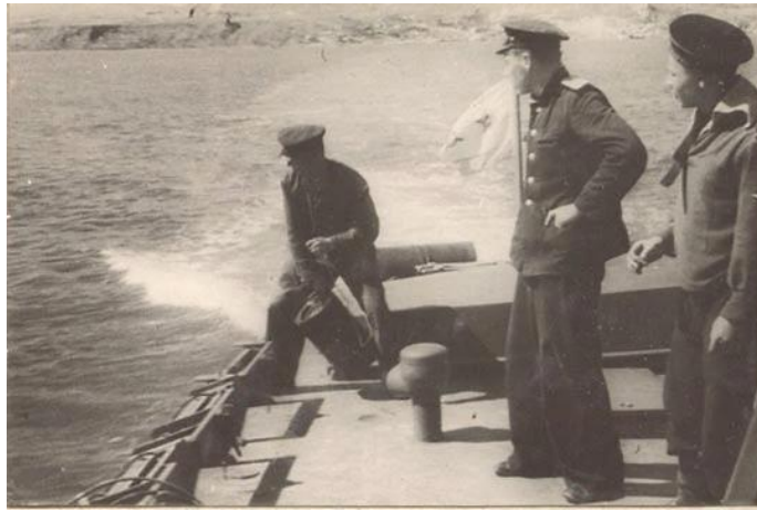
Расчистка зоны строительства моста: метание глубинных бомб для подрыва контактных мин
