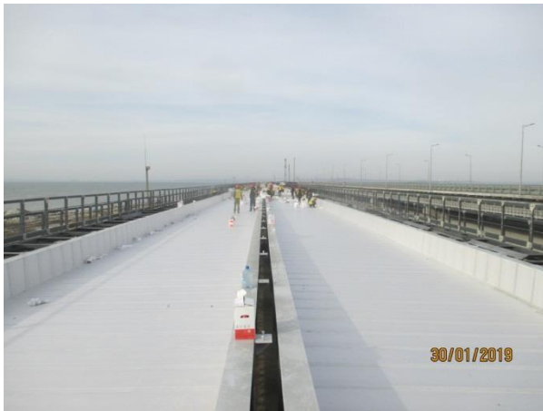
ПС в осях опор №111-№114 - ж/д мост. Оси А-Б (путь №1), В- Г (путь №2). Устройство защитного слоя гидроизоляции (системы Элиминатор) балластного корыта. Укладка на клей-пену плит из экструдированного пенополистирола с заделкой швов лентой "Герлен-Д".01.2019
