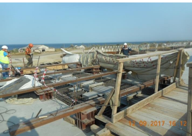
Опора №163 (а/д мост). Приемочный контроль устройства деформационного шва плиты проезжей части, в осях главных балок 3-4. 09.2017
