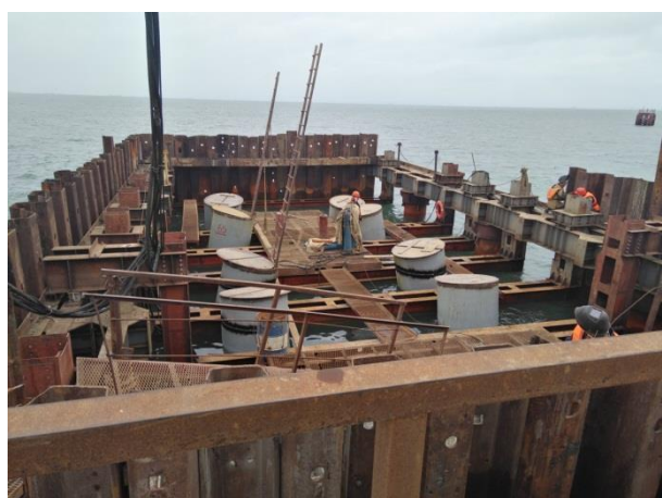
Опора № 93 ж/д мост. Устройство свайного основания опоры. Устройство волнозащиты. Срезка оголовков металлических свай Ø1420 мм. на проектную отметку. 05.2018
