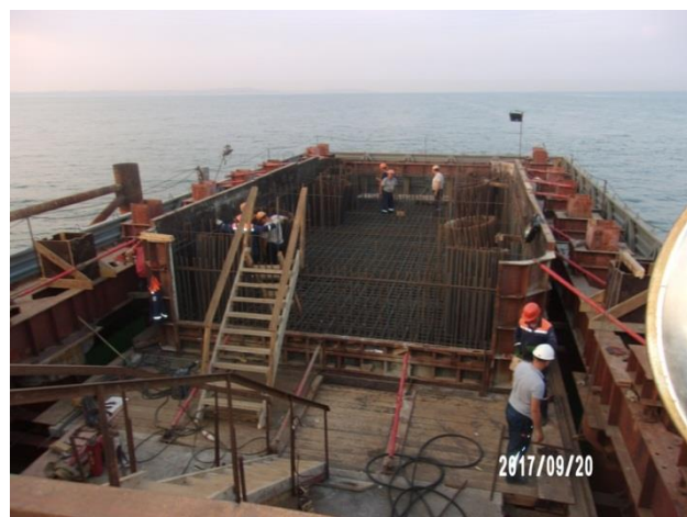
Опора № 94 (а/дорога). Устройство монолитного ростверка опоры. Армирования и установка опалубки монолитного ростверка опоры, I этап бетонирования. 09.2017
