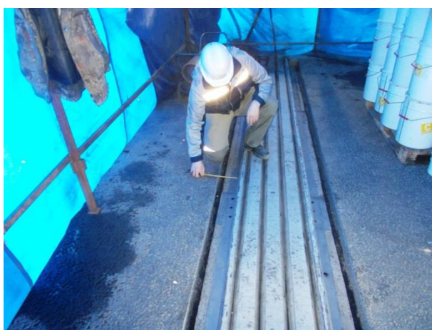
Опора № 195, оси 3 – 4 (а/д мост). Приёмочный контроль геометрических размеров штрабы под заполнение полимербетоном вдоль деформационного шва. 04.2018
