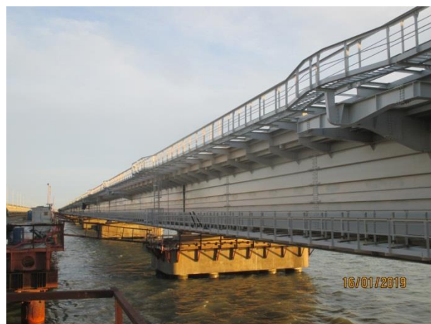
Пролетное строение в осях опор №82-№104 (ПСЗ) - ж/д мост. Оси опирания А, Б, В, Г. Участок №3 «Протока». Смонтированные пролетные строения. 01.2019
