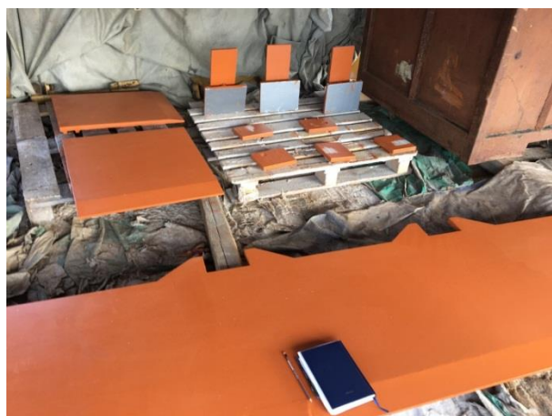
Деформационный шов над опорой № 121 ж/д мост. Устройство гидроизоляции деформационного шва и участка примыкания балластного карыта в осях главных балок В-Г. Нанесенный праймер Zed S94 перед нанесением гидроизоляционного материала Eliminator. 11.2018
