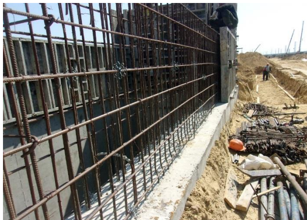
04.2018 г. Работы выполняет ООО «Вектор». Пешеходный тоннель на ПК323 +16. Армирование и установка опалубки подпорной стенки лестничного схода ЛС2.
