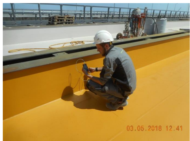
Железнодорожное пролетное строение в осях опор 189-192 ж/д. Устройство гидроизоляции металлических балластных корыт системой Элиминатор. Контроль толщины гидроизоляционного слоя. 05.2018
