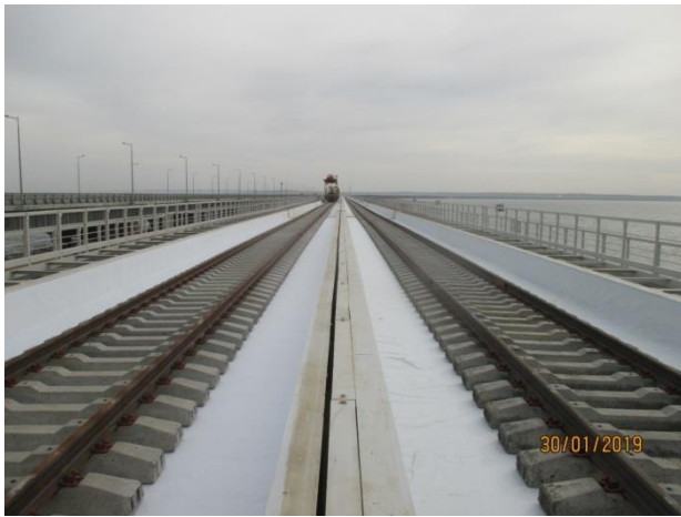
ПС в осях опор №82-№106 (оси А- Б, путь №1); №82-№103 (оси В-Г, путь №2). Ж/д мост. Устройство верхнего строения пути. Укладка рельсошпальных решеток. 01.2019
