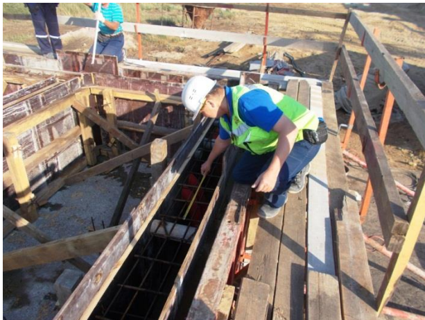
Приёмочный контроль изготовленного арматурного каркаса и установленной опалубки фундамента модуля связи.08.2018
