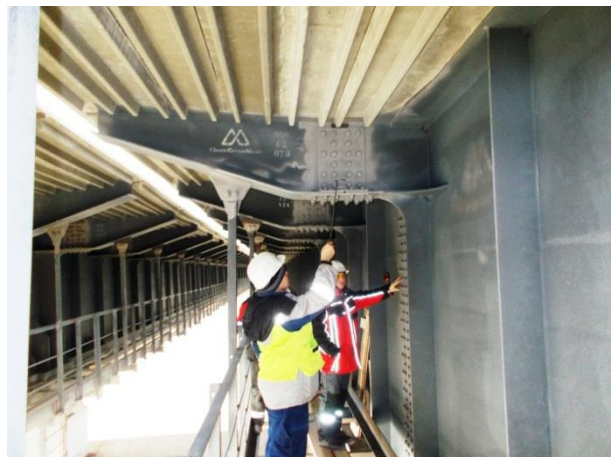
Пролётное строение в осях опор № 201 – 202 (а/д мост), ось 3. Приёмочный контроль качества пескоструйной очистки болтовых соединений стыка консоли. 02.2018
