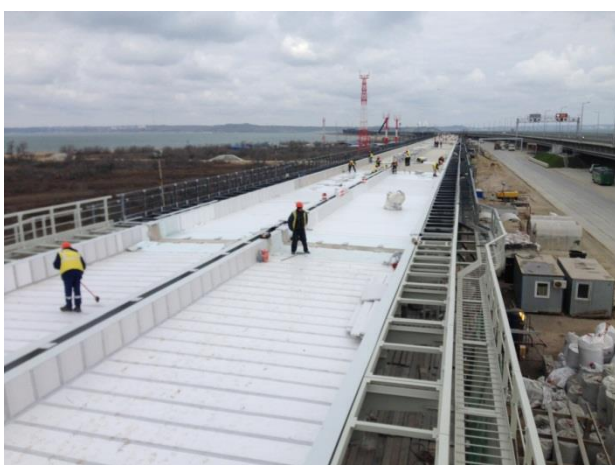
Устройство защитного слоя балластного корыта из пенополистирола. Вид от опоры №174 в сторону Керченского полуострова (ж/д мост). 03.2019
