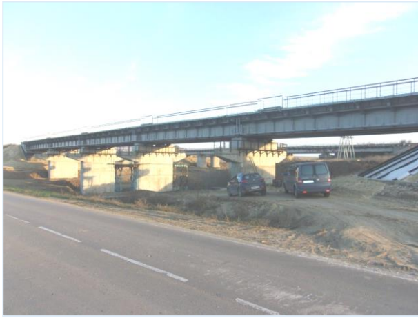
10.2016 г. Работы ведёт ООО «ТЮС-КубаньМост». Железнодорожный мост на ПК169+50.
