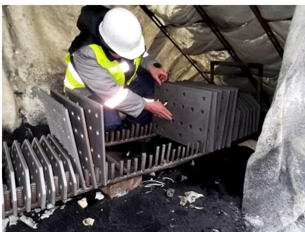
А/д мост. Приемочный контроль качества абразивоструйной очистки контактных поверхностей стыка накладок. 01.2017
