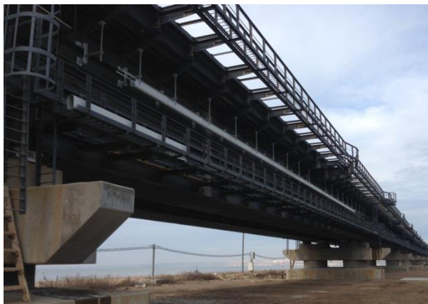
ПС в осях опор 195-196, 199-200 (ж/д мост). Устройство водоотводной системы. 01.2019
