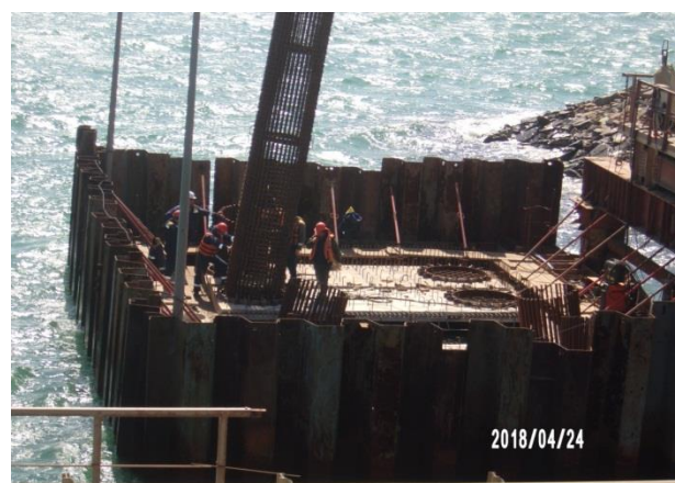
Опора № 103 (ж/д мост). Устройство свайного основания опоры. Железобетонное заполнение. Установка арматурных каркасов в полости металлических свай \varnothing 1420 мм. 04.2018
