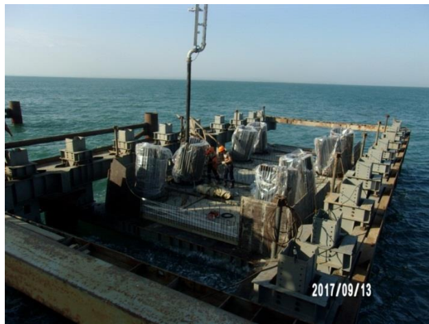
Опора № 93 (а/дорога). Устройство свайного основания опоры. Бетонирование полостей металлических свай Ø1420. 09.2017
