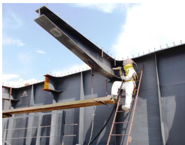
Пролёт 204 – 205, п.с. 15 ось 1. Устройство сталежелезобетонного пролётного строения (а/д мост). Абразивоструйная очистка контактных поверхностей консолей. 07.2017
