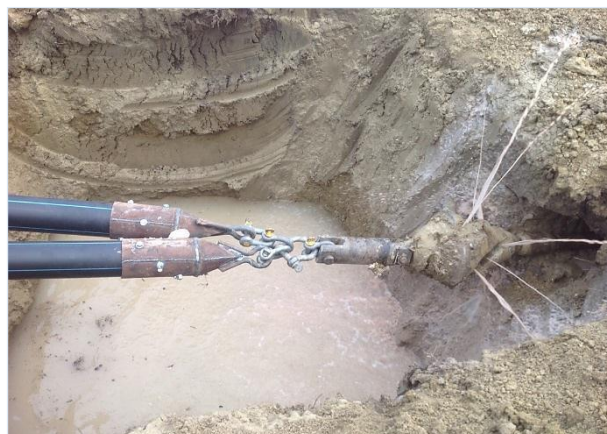
06.2015. Работы ведет ООО «ГазСтрой». Переустройство магистрального газопровода на ПК20+96. Протаскивание футляров ПЭ Ø160 мм в приемный котлован.
