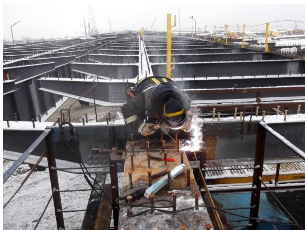
Пролёт 176 – 178 (а/д мост). Сварка верхнего пояса главных балок, ось 3. 01.2017
