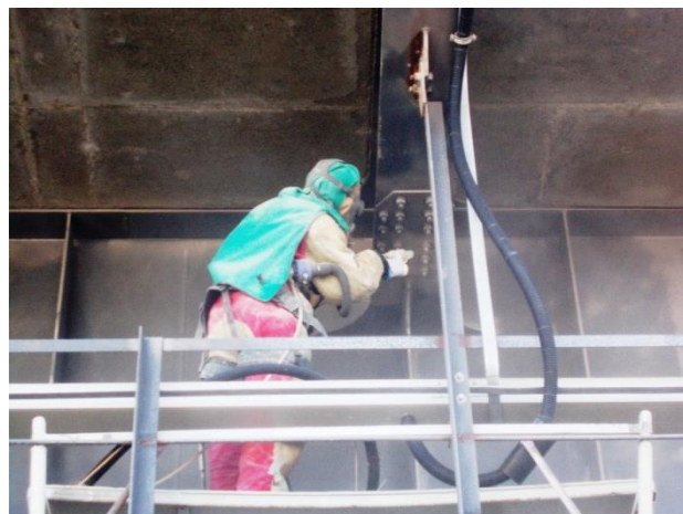
Пролётное строение в осях опор № 188 – 189 (а/д мост), ось 1. Пескоструйная очистка болтового соединения консоли. 04.2018
