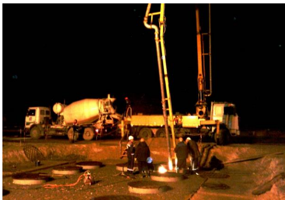
Опора № 204 (ж/д мост). Бетонирование тампонажного слоя в полости трубосвай. 05.2017
