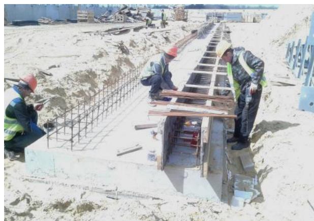
04.2018г. Работы ведет ООО "НПО "СПбЭК". Тяговая подстанция Вышестеблиевская (открытая часть). Операционный контроль работ по устройству опалубки и армированию ПФм7
