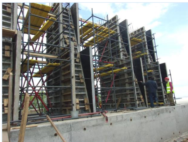
05.2016 г. Работы выполняет ООО «ТЮС Арена». Автодорожный путепровод на ПК42+93,61. Устройство стоек монолитных СМ1 на опоре №4.
