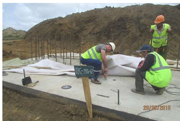
05.2015. Работы ведет ООО «Мостовое бюро». Контроль прочности бетона ростверка опоры №2 металлического моста на ПК203+47 склерометром «Шмидта».
