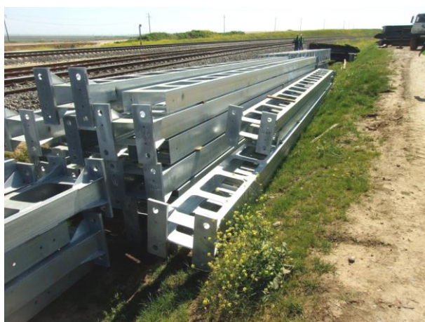
05.2016 г. Входной контроль металлоконструкций опор ж. д. контактной сети (производитель СМР подрядная организация ООО «ТЮС-МКС»).
