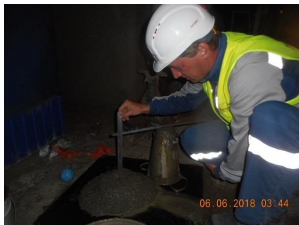
Опора №151 (ж/д мост). Входной контроль бетонной смеси для бетонирования подферменных площадок. 06.2018
