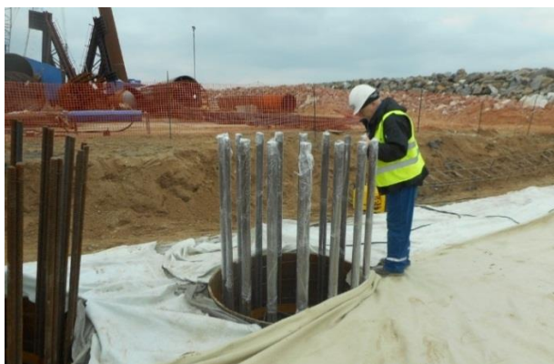
Опора №194 (а/д мост). Приемочный контроль смонтированных пространственных каркасов в полости трубосвай. 11.2016
