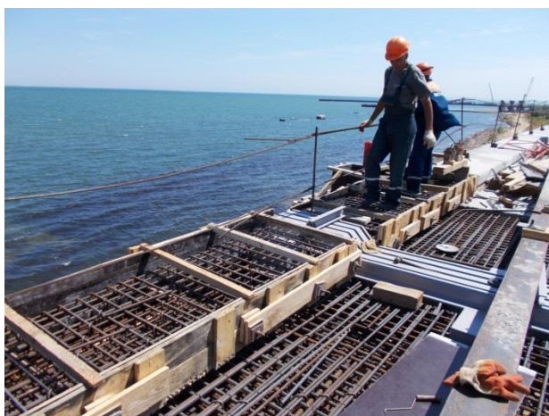
Опора №195 (а/д мост), оси 3 - 4. Изготовление опалубки консоли монолитной части деформационного шва. 08.2017
