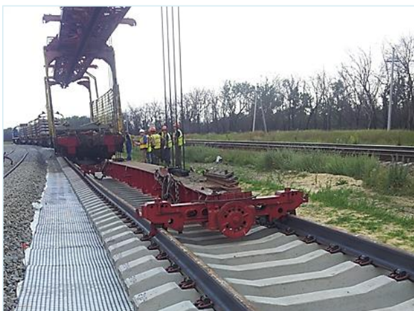
06.2015. Работы ведет ООО "ТЮС Путь". Укладка РШР ПК 15+80-ПК 23+00.
