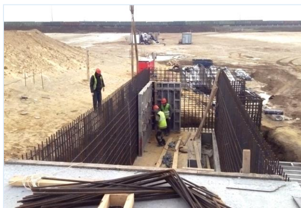
11.2017 г. Работы выполняет ООО «Вектор» (г.Реутов). Строительство пешеходного тоннеля на ПК323+16.Выполняются работы по монтажу опалубки секции Умс-1.
