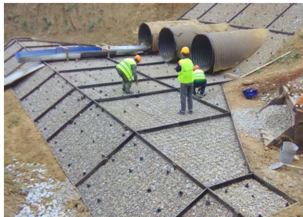
05.2018г. Работы выполняет ООО «ЮжГазСтрой». Водопропускная труба СМГТ на ПК247+14,3. Выполняются работы по армированию укрепления входного оголовка.
