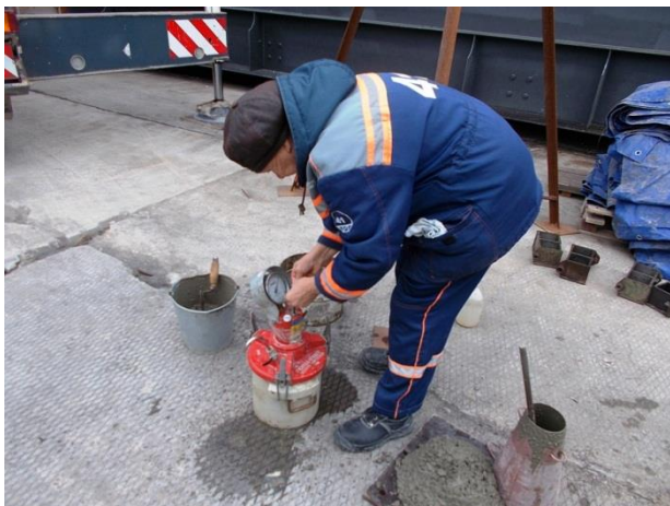
Опора № 171 (ж/д мост). Проверка воздухововлечения при входном контроле бетонной смеси, перед бетонированием подферменников опоры. 11.2017
