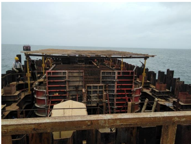
Опора № 91 ж/д мост. Устройство монолитного ростверка опоры. Армирование и установка опалубки ростверка. 05.2018
