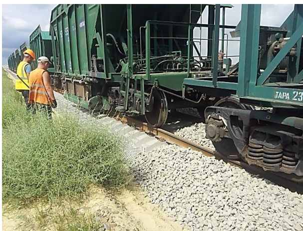
07.2015. Работы ведет ООО «ТЮС-Путь». Балластировка пути ПК 23-ПК 26.
