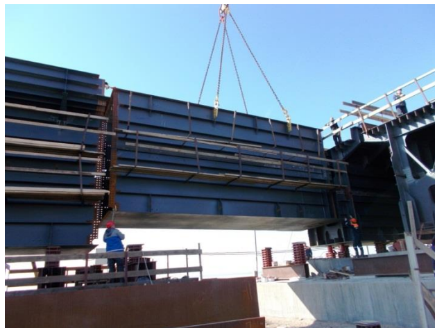
Пролётное строение в осях опор № 188 – 189, оси А – Б (ж/д мост). Монтаж укрупнённого блока в пролёт на временные опоры. Блоки Б1т/Б2т. 11.2017
