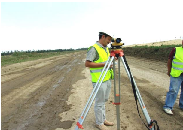
07.2015. Работы ведет ООО «Мостовое бюро». Контрольная геодезическая проверка высотного положения цементно-грунтового основания притрассовой автодороги ПК71+60 – ПК78+60.
