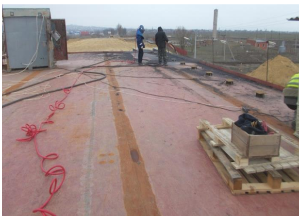
03.2018г. Работы выполняет ООО «Зодчий». Автодорожный путепровод на ПК267+50. Выполняются работы по абразивоструйной очистке поверхности ортотропной плиты проезжей части перед устройством клеечной гидроизоляции.
