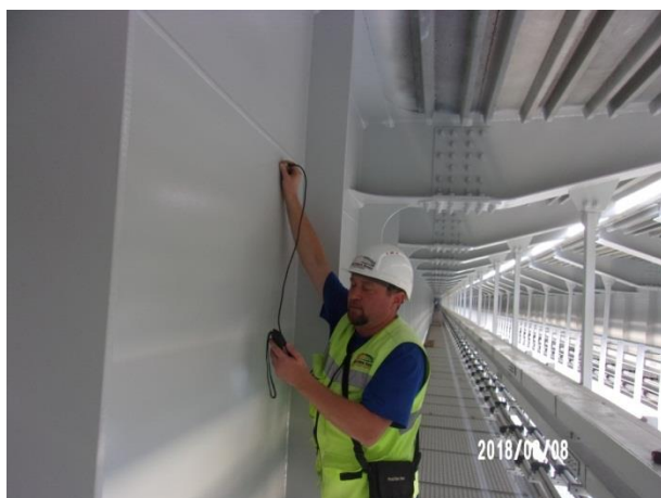
Пролётное строение в осях опор №№ 113-114 а/д мост. Освидетельствование нанесенного финишного слоя Nemphane HS 55610. Промер толщин сухой плёнки ЛКП. 08.2018
