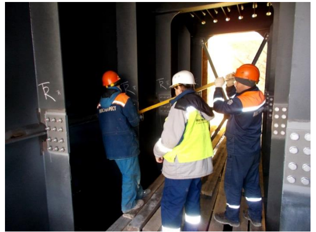
Пролётное строение в осях опор 167 – 168, оси А – Б. Устройство металлического пролётного строения (ж/д мост). Проверка качества натяжения на расчётное усилие высокопрочных болтов. Стыки крепления блока Б3т к блоку Б4т. 12.2017
