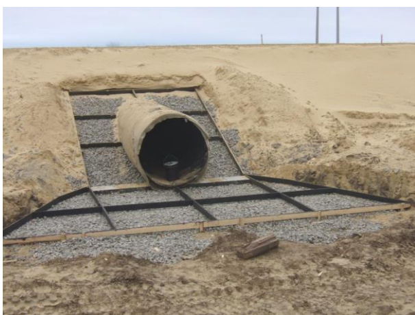
12.2015г. Работы ведет ООО «СМП Трансстрой». Устройство щебёночной подготовки для укрепления откосов и русла. Труба на ПК143+65.
