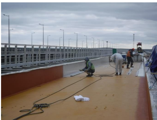
ПС в осях опор №107-№108 (ось В-Г) - ж/д мост. Антикоррозионная защита внутренних поверхностей балластного корыта. Нанесение гидроизоляционной мембраны Элиминатор на поверхности балластного корыта. 01.2019
