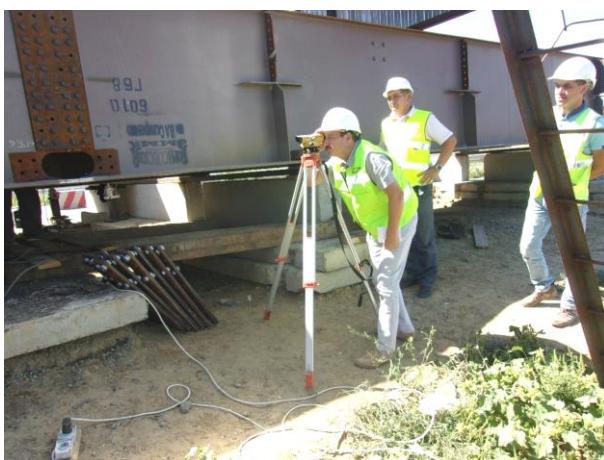
08.2016 г. Работы выполняет ООО «Мостовое бюро». Автодорожный путепровод на ПК42+93,61. Освидетельствование сварных швов блоков на укрупнительном стапеле и контроль строительного подъёма.
