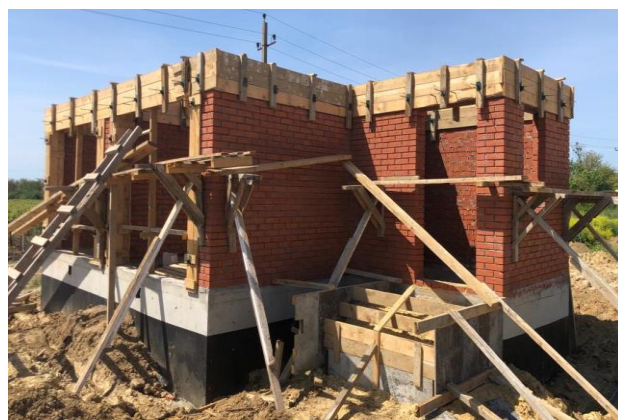
05.2019г. Работы выполняет ООО «КУРОРТСТРОЙИНВЕСТ». Инфраструктура караульных городков станция Вышестеблиевская. Вольер для собак на 2 головы.
