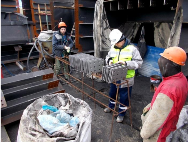
Устройство металлического пролётного строения (ж/д мост). Контроль качества абразивоструйной очистки контактных поверхностей накладок. 12.2017
