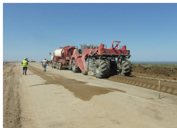
08.2015. Работы ведет ООО «Интегра». Притрассовая автодорога ПК132+00 – ПК135+00. Устройство цементно-грунтового основания методом холодного ресайклинга.
