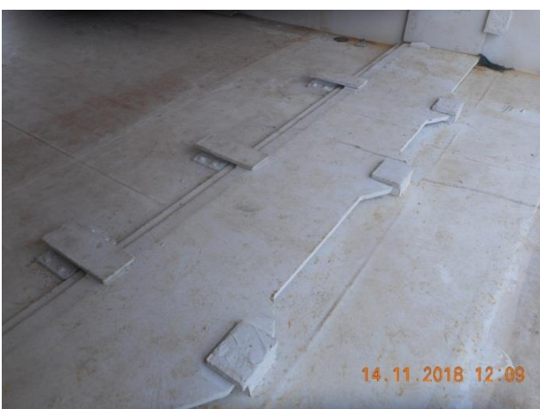
Деформационный шов над опорой № 101 ж/д мост. Смонтированный деформационный шов после нанесения гидроизоляции системой Eliminator в осях главных балок В-Г. 11.2018
