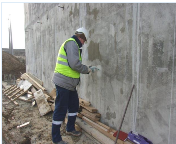
01.2016 г. Работы ведет ООО «Мостовое бюро». Железнодорожный путепровод на ПК237+76. Испытания неразрушающим методом по ГОСТ 22690-88, монолитного железобетонного тела опоры №2, склерометром «N34».
