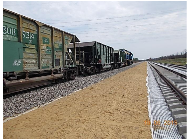
06.2015. Работы ведет ООО "ТЮС Путь". Выгрузка балласта из хоппер-дозаторов на ЗП ПК 17+00-ПК 20+00.
