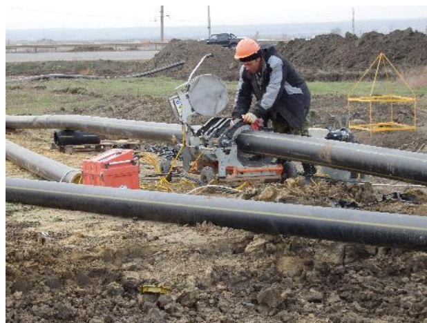
10.2018г. Работы ведет ООО «ТеплоГазСервис». Внешние сети газоснабжения. Ст. Тамань-Пассажирская. Операц. контроль работ по сварке труб магистрали газопровода из труб ПЭ100 SDR11 225*20,5 на ПК18+00 – ПК19+00.
