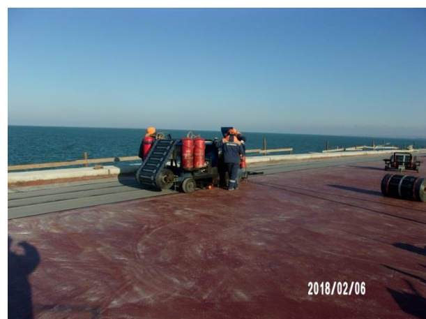
Пролётное строение в осях опор №№ 92-93 (а/д мост). Устройство гидроизоляции плиты проезжей части в осях главных балок 3-4 из наплавляемого рулонного материала Техноэластмост С. 02.2018
