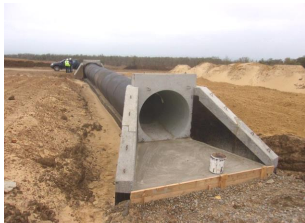
10.2015г. Работы ведёт ООО «ТЮС – Север». Сооружение водопропускной трубы КЖБТ отв. 1,25 м под ж.д. полотном на ПК226+0,3.
