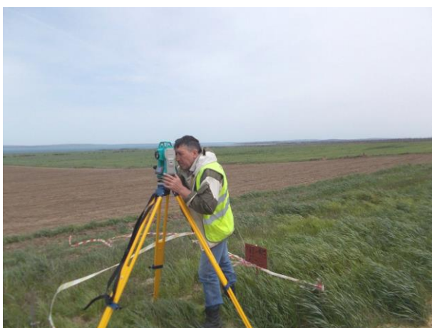
04.2016 г. Работы ведет ООО «Мостовое бюро». Геодезический контроль укладки рельсошпальной решетки 2 путь. ПК63+00-ПК67+00.
