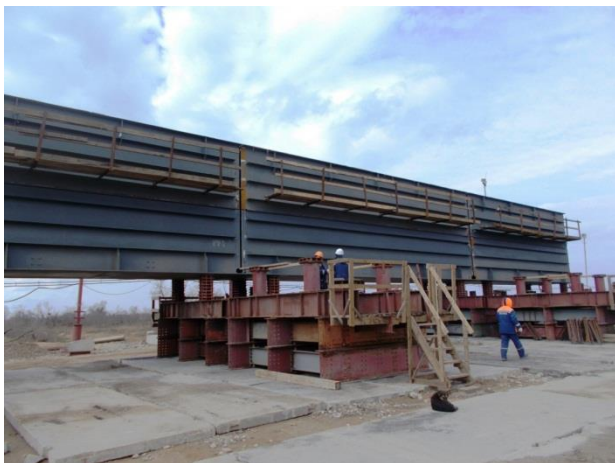
Пролётное строение в осях опор № 172 – 173, оси А – Б (ж/д мост). Укрупнительная сборка балок пролётного строения. 04.2018
