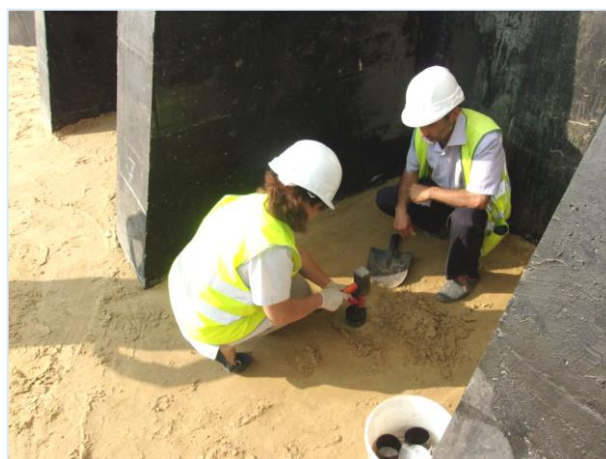
07.2016г. Работы ведёт ООО «ТЮС-КубаньМост». Ж/д путепровод на ПК237+76,95, устройство застойной засыпки опоры 2 и подпорных стен опоры 2 (6-й слой). Отбор проб уплотнённого дренирующего грунта методом режущего кольца.
