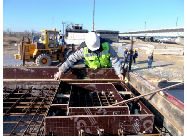
Опора № 169 (ж/д мост). Приёмочный контроль установленной опалубки и арматурного каркаса подферменников. 12.2017
