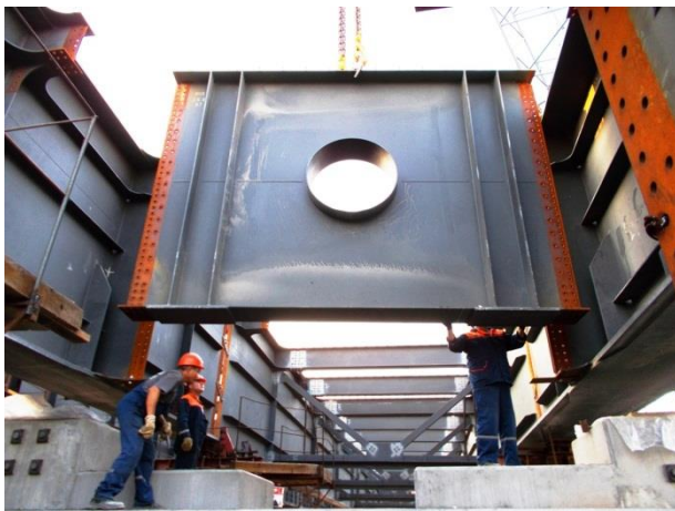
Опора № 207, оси 1 – 2. Монтаж домкратной балки. 08.2017
