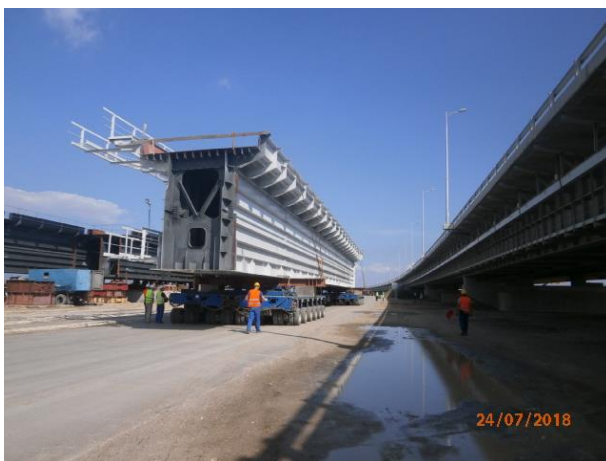
Пролётное строение в осях опор № 84-85 (ж/д мост). Транспортировка и поперечная подвижка металлического пролетного строения в осях главных коробчатых балок А-Б. 07.2018
