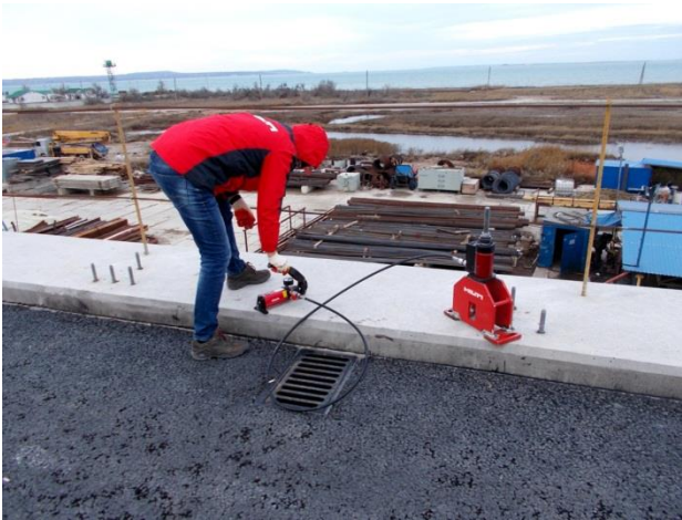
Пролётное строение в осях опор 171 – 175, ось 4. Устройство железобетонного пролётного строения (а/д мост). Испытание анкеров барьерного ограждения. 12.2017
