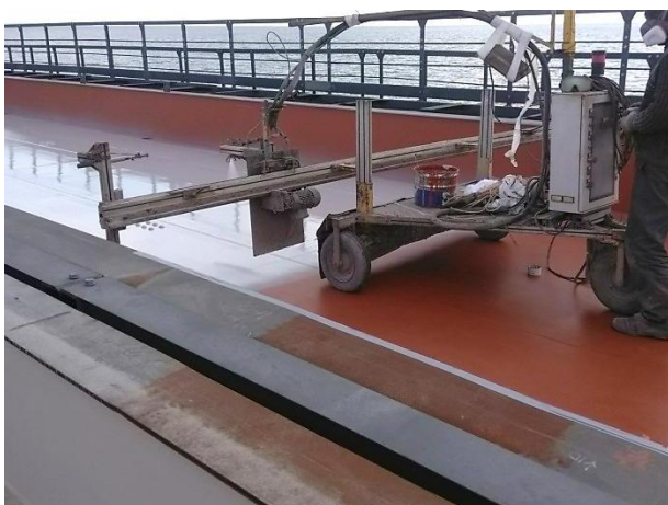
Пролётное строение в осях опор 203-204 ось А-Б (ж/д мост). Устройство гидроизоляции, нанесение водонепроницаемой мембраны Eliminator на поверхность балластного корыта. 03.2019
