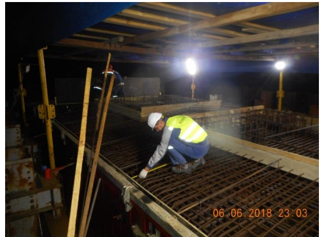
Опора №92 (ж/д мост). Приемочный контроль устройства арматурного каркаса и опалубки ростверка. 06.2018
