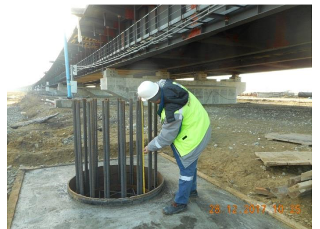
Опора №137 (а/д мост). Приёмочный контроль смонтированных арматурных каркасов в полости трубосвай №1, №3, №4, №6 АСУДД №4 . 12.2017
