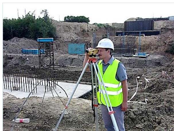
07.2015. Работы ведет ООО «Мостовое бюро». Геодезический контроль высотного положения ростверков опор железнодорожного моста на ПК169+50.
