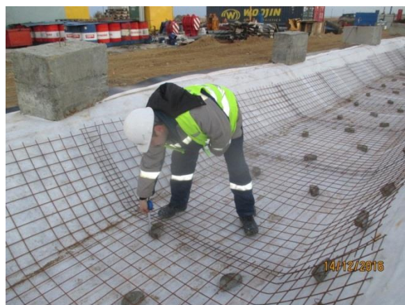
Накопительный резервуар. Измерение защитного слоя. 12.2016
