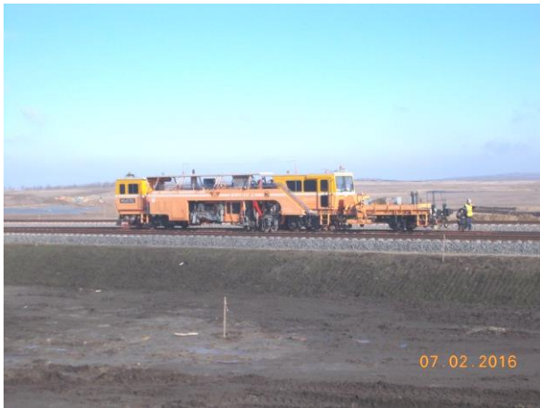
02.2016г. Работы ведет ООО «ТЮС Путь». Подъемка и выправка РШР ПК 25+00-ПК32+00 2 путь.
