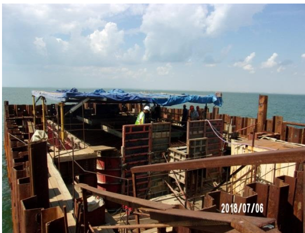
Опора № 93 (ж/д мост). Устройство монолитного ростверка опоры. Армирование и установка опалубки. 07.2018
