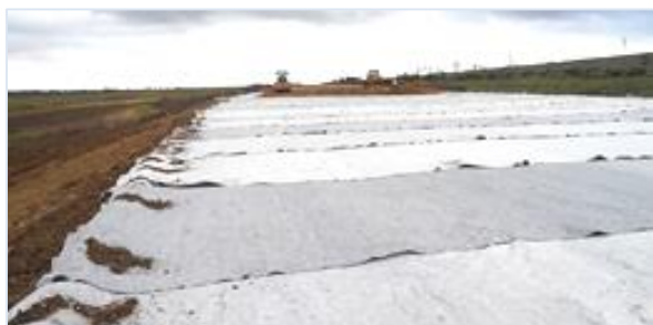
06.15 г. Работы ведет ООО"ТЮС МК-105". Устройство грунтовой обоймы в теле насыпи, устройство нижнего слоя насыпи ЗП под ж.д. путь местными грунтами из карьера ПК33+ПК34.20.
