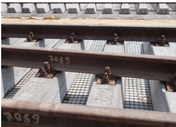
08.2016г. Работы ведет ООО «ТЮС-Путь». Приемочный контроль работ по устройству верхнего строения пути. ст. Вышестеблиевская.
