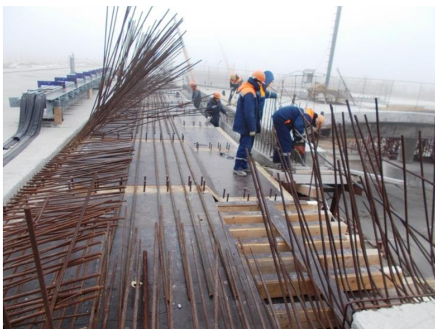
Пролётное строение в осях опор № 167-168-169, ось 1 (а/д мост). Устройство железобетонного пролётного строения. Изготовление опалубки монолитной части деформационного шва к съезду на остров Тузла. 11.2017
