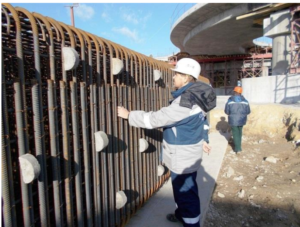
Опора № 168 (ж/д мост). Приемочный контроль устройства арматурного каркаса ростверка. 11.2017
