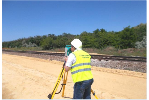
05.2017г. Работы ведет ООО «Мостовое бюро». Ст. Вышестеблиевская. Геодезический контроль плано-высотного положения верха защитного слоя и откосов насыпи земляного полотна на ПК943+50 – ПК949+00.
