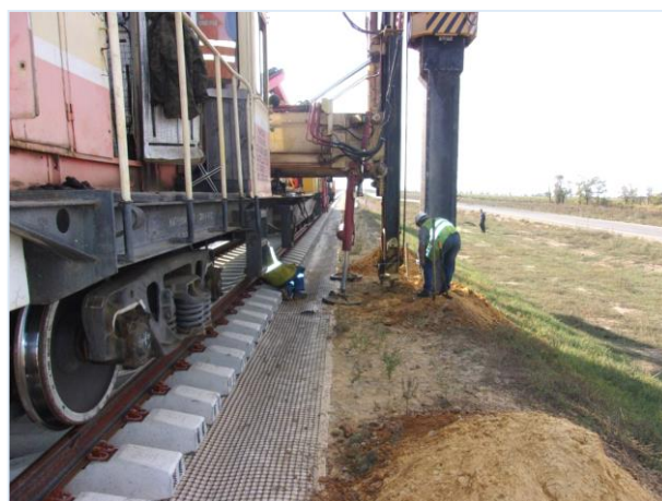
09.2016 г. Работы ведёт ООО «ТЮС-МКС». Устройство ж. д. контактной сети на участке ПК14+00-ПК126+00.
