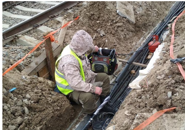
03.2018г. Работы выполняет ООО «ТЮС-СЦБ» Ст.Вышестеблиевская. Устройства ЭЦ-ЕМ. Устройство соединительных муфт.
