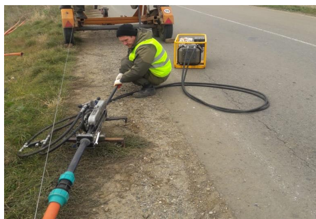
11.2018г. Работы ведет ГК «Спецвектор». Ж/д км0-км40. Система сбора и обработки информации. Операционный контроль работ по протаскиванию кабеля в трубы ЗПТ.
