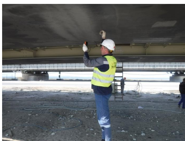
Пролетное строение в осях опор №110-№111 (ж/д мост). Приемочный контроль толщины грунтового слоя на металлоконструкциях пролётного строения в осях А-Б, В-Г, низ нижнего пояса. 05.2019
