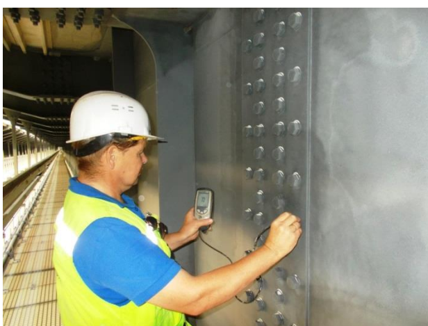
Пролётное строение в осях опор 156 – 157, ось 3. (а/д мост). Приемочный контроль толщины грунтовочного покрытия болтовых соединений. Толщина покрытия соответствует требованию рабочей документации. 08.2018
