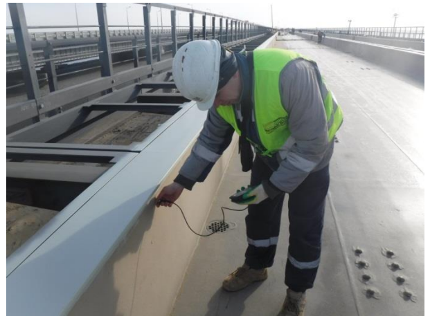
Пролетное строение в осях опор №113- №114 (ось Б-В) - ж/д мост. Антикоррозионная защита внутренних поверхностей балластного корыта. Нанесение гидроизоляционной системы Элиминатор на поверхности балластного корыта. Приемочный контроль качества (визуально-измерительный контроль) нанесенной гидроизоляционной системы Элиминатор на внутренние поверхности балластного корыта. 01.2019
