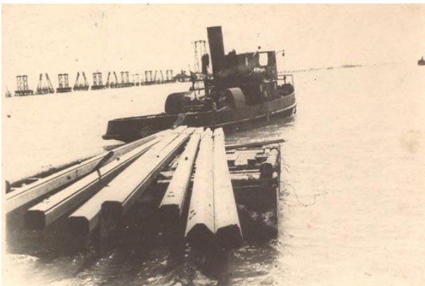
Доставка свай к месту забивки на понтонах
