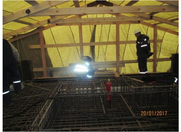
Опора №83 (ж/д мост). Приемочный контроль арматурного каркаса и установленной опалубки ростверка и тела опоры(2-й этап бетонирования). 01.2017
