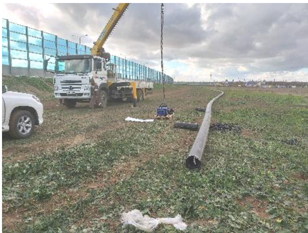
12.2018г. Работы ведет ООО «ТеплоГаз Сервис». Внешние сети газоснабжения ст. Тамань-Пассажирская. Операц. контроль работ по дефектоскопии сваренной магистрали газопровода из труб ПЭ 100 SDR11 ду 225*20,5 ПК25+93 – 31+00.
