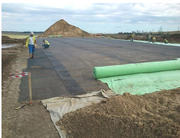
07.2015. Работы ведет ООО «МК 105». Укладка георешетки и геотекстиля ПК 36+20 – ПК 36+70.
