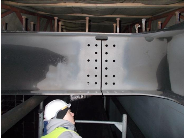
Пролет 128-129, ось 4 (а/д мост). Приемочный контроль абразивоструйной обработки стыка поперечной балки ПБ22. 01.2017
