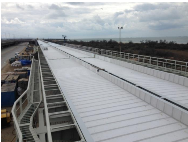
Устройство защитного слоя балластного корыта из пенополистирола. Вид от опоры №174 в сторону Таманского полуострова (ж/д мост). 03.2019
