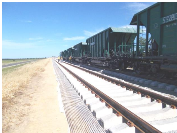
07.2016г. Работы ведет ООО «ТЮС- Путь». Операционный контроль балластировки 1-го пути балластным щебнем ПК 145+50-ПК 147+00.
