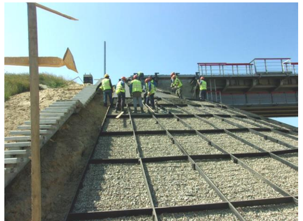
06.2017 г. Работы выполняет ООО «ТЮС-КубаньМост». Железнодорожный мост на ПК169+50. Укрепление монолитным бетоном откоса конуса опоры №1.
