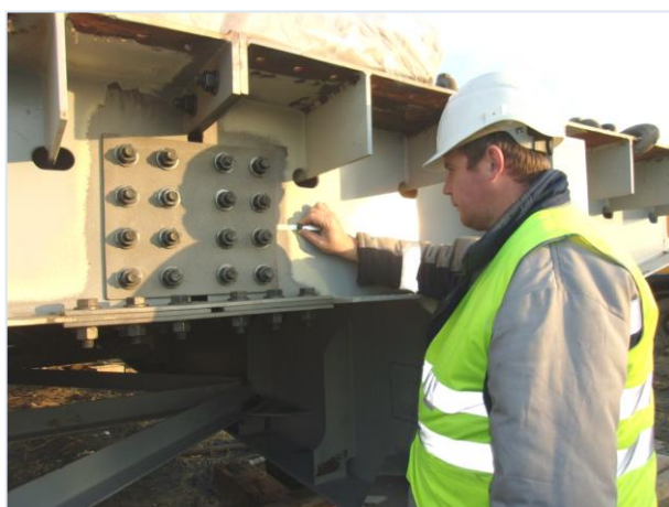
12.2015 г. Работы выполняет ООО «ТЮС - КубаньМост». Железнодорожный мост на ПК203+47,
