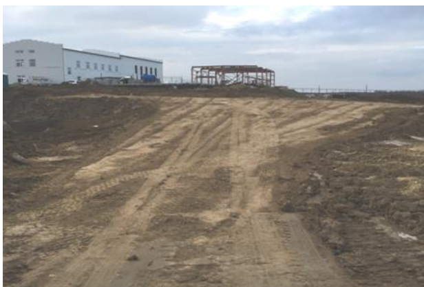
01.2019 г. Работы выполняет ООО «ТЮС-СМП-608» Ст. Тамань-Пассажирская. Съезд №1 на ПК500. 5-ый слой насыпи земляного полотна.
