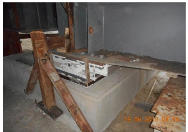
Опора №147 (ж/д мост). Приемочный контроль устройства опалубки ростверка под подливочную смесь опорных частей. 06.2018
