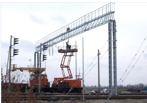
11.2017г. Работы выполняет ООО «ТЮС- МКС». Контактная сеть. Перегон Вышестеблиевская - О.П. 22км.ВЛ 10кВ ПЭ. Монтаж кронштейнов на ригелях.
