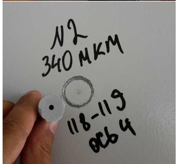
Пролётное строение в осях опор № 118-119 (а/д мост). Устройство антикоррозионной защиты стальных конструкций пролётного строения в осях главных балок 4 (фасад). Проведение испытаний по определению адгезии методом отрыва нанесенного лакокрасочного покрытия. 07.2018
