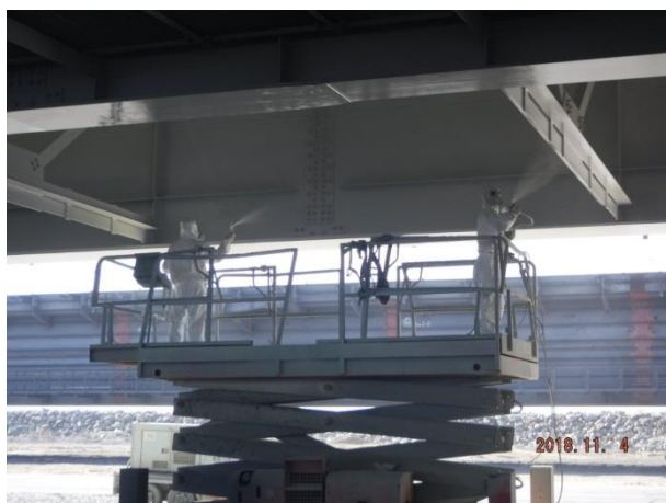
Пролётное строение в осях опор №№ 62-63 а/д мост. Устройство антикоррозионной защиты стальных конструкций пролётного строения в осях главных балок А-Б (внутренние межбалочные поверхности). Нанесение финишного слоя антикоррозионной защиты Nempathane HS 55610. 11.2018
