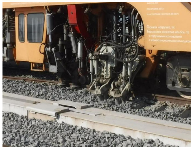
ПС в осях 95 – 96, ж/д мост, II путь, работы по выдергиванию рельсошпальной решетки на первый слой, а также – по черновой рихтовке и выправке пути. Производятся машиной ВПСР-03.2. 03.2019
