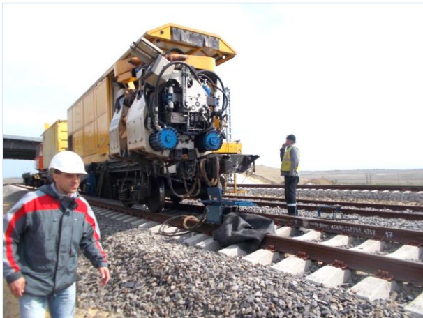
04.2017г. Работы ведет ООО «ТЮС Транс». Путьевое развитие. ст. Тамань–Пассажирская. Операционный контроль устройства бесстыкового пути, сварка звеньев рельс Р65 на ПК27+00 – ПК29+00 II путь.
