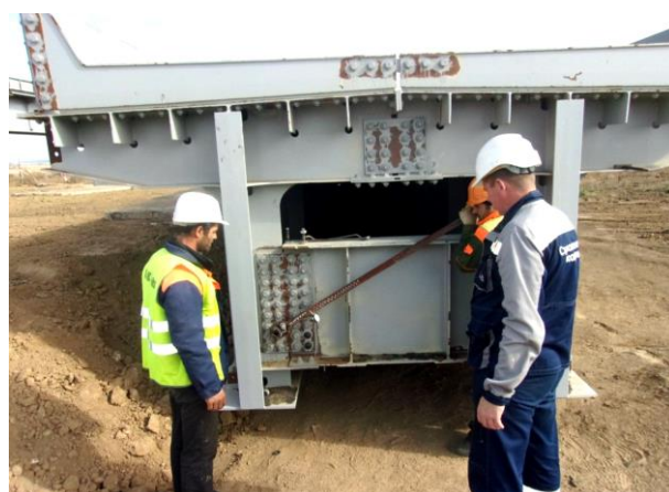
10.2015г. Работы выполняет ООО «ТЮС - КубаньМост». Сооружение железнодорожного моста на ПК169+50, укрупнительная сборка металлоконструкций пролётногo строения 1-2. Приёмка натяжения высокопрочных болтов на требуемое усилие.
