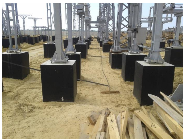
05.2018г. Работы ведет ООО «НПО «СПбЭК». Тяговая подстанция Ст.Вышестеблиевская (открытая часть). Устройство заземления (2 котлован).
