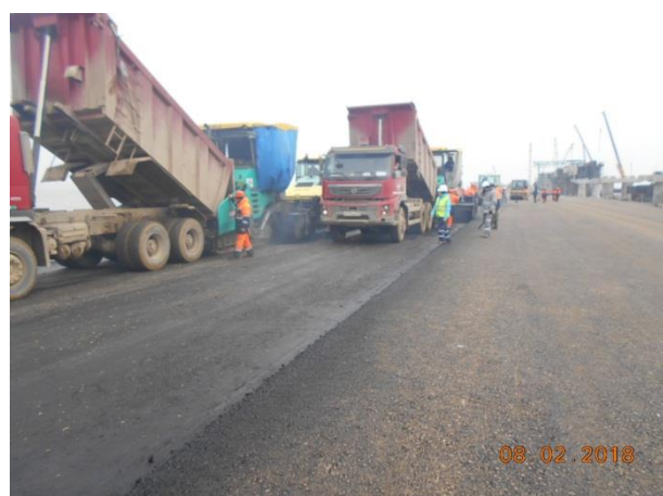
Дорожная часть. Керчь. Участок №8. Автомобильная дорога. Дорожная одежда. Устройство верхнего слоя основания из, а/б высокопористого горячего крупнозернистого марки 1 Н-14 см. 02.2018
