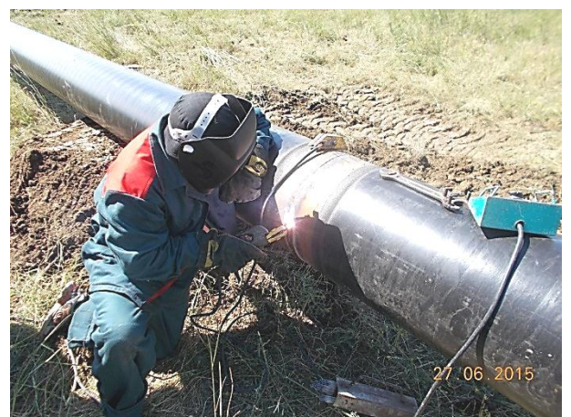
06.2015. Работы ведет ООО "Газстрой". Переустройство магистрального газопровода ПК 253+96. Монтаж футляра.
