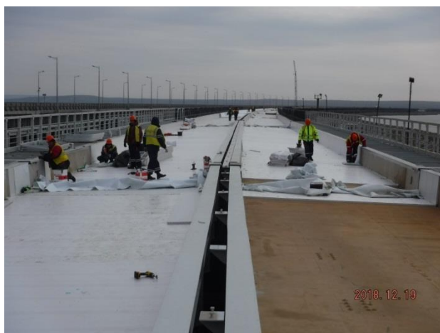
Пролётные строения в осях опор №№ 82-83, 83-84 ж/д мост. Устройство верхнего строения пути в осях главных балок А-Б, В-Г. Устройство защитного слоя гидроизоляции балластного корыта из пенополистерола с заделкой швов лентой "Герлен-Д". 12.2018
