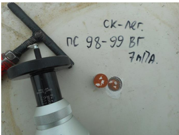
Пролётное строение в осях опор №№ 98-99 ж/д мост. Устройство гидроизоляции балластного карыта системой Eliminator в осях главных балок В-Г. Проведение испытаний по определению адгезии методом отрыва нанесенной гидроизоляции на днище балластного карыта. 11.2018
