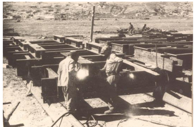
Изготовление металлических ростверков постоянных опор
