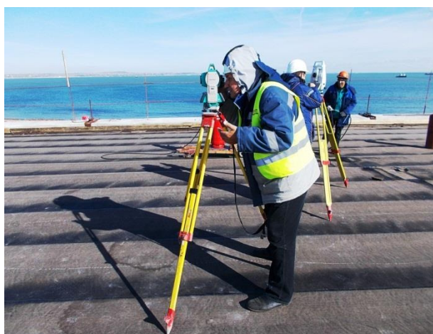
Пролётное строение в осях опор № 203-207, оси 3 – 4 (а/д мост). Устройство сталежелезобетонного пролётного строения. Приемочный контроль установленной копирной струны. 11.2017
