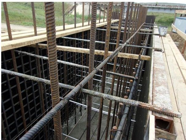
06.2015. Работы ведет ООО «ТЮС-КубаньМост». Металлический мост на ПК203+47. Армирование тела опоры №3 (2 этап).
