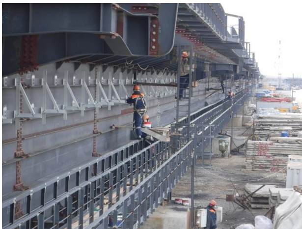
ПС в осях 108 – 109, ж/д, ось Г, устройство водоотведения и ЛОС железнодорожного моста. Установка композитных пултрузионных элементов рамы крепления водоотводного лотка. 03.2019
