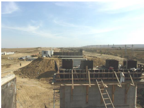
10.2015 Работы ведёт ООО «ТЮС-КубаньМост». Общий вид на железнодорожный мост на ПК203+47.
