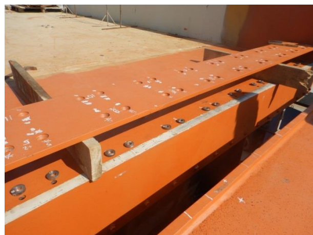
Опора 191(ж/д мост). Установка выравнивающего листа на компенсационные шайбы. Контроль гидроизоляции. 08.2018
