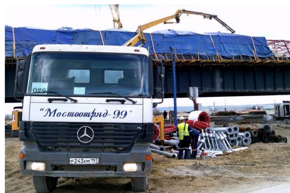
Пролёт 183 – 187, п.с. 12/2, оси 3 – 4, захватка 1. (а/д мост). Устройство сталежелезобетонного пролетного строения. Бетонирование плиты проезжей части. Подача бетонной смеси. 04.2017
