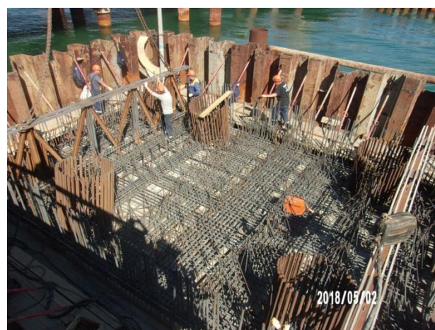
Опора № 103 ж/д мост. Устройство монолитного ростверка опоры. Армирование ростверка. 05.2018
