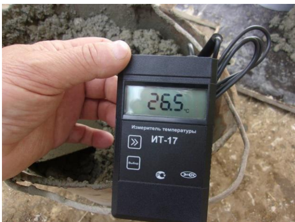
05.2017 г. Работы выполняет ООО «Мостовое бюро». Железнодорожный мост на ПК203+47. Входной контроль бетонной смеси монолитного упора конуса опоры №4.
