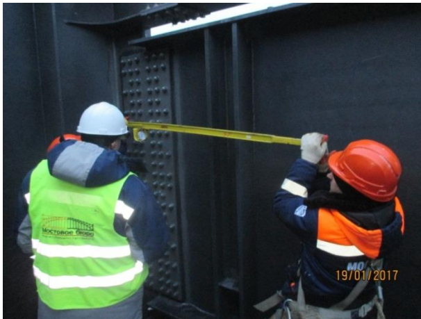
Пролет 82-83 (а/д мост). Ось А. Контроль натяжения высокопрочных болтов на расчетное усилие в узлах прикрепления домкратной балки ДБ1. 01.2017
