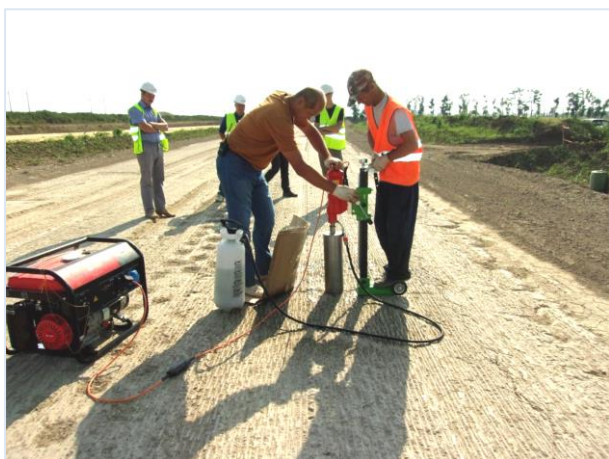
07.2015. Работы ведет ООО «Интегра». Комиссионное выбуривание керна по поперечной трещине цементно-грунтового основания притрассовой автодороги ПК81+00 – ПК84+00.
