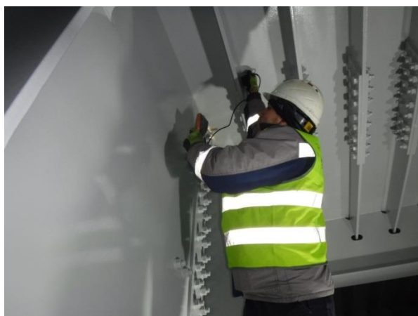
ПС в осях 134 – 135, ж/д, А-Б, внутренние поверхности. Устройство антикоррозионной защиты стальных конструкций пролётного строения. Приемочный контроль качества (визуально-инструментальный контроль) и толщины сухой пленки системы антикоррозионного покрытия Непрел. Покрытие соответствует V классу по ГОСТ 9.032, ТСП не менее требуемой по «ТР по АКЗ СК ПС в усл. Монтажной площадки». 03.2019
