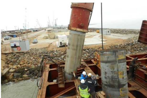
Опора №103 (а/д мост). Динамические испытания сваи. 11.2016
