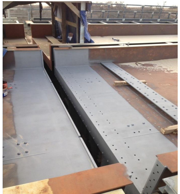
Устройство гидроизоляции деформационного шва на опоре 167, оси В,Г (ж/д мост). Абразивоструйная обработка пролетных строений в зоне деф. шва и выравнивающий лист перед нанесением праймера Zed S94. 01.2019
