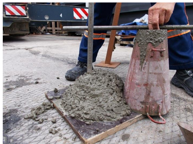
Опора № 171 (ж/д мост). Проверка подвижности бетонной смеси при входном контроле, перед бетонированием подферменников опоры. 11.2017
