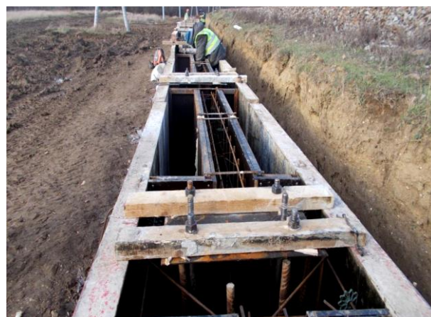
12.2017г. Работы выполняет ООО «НСТЭ». Шумозащитный экран ПК0,0-ПК12+50. Установка опалубки, армирование ростверков.
