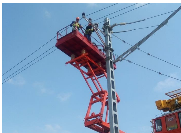
06.2018г. Работы выполняет ООО «ТЮС- МКС». Участок О.П. 22 км – 26 км. ВЛ 10 кВ ПЭ. Выполняются работы по монтажу изоляторов линии СИП-3
