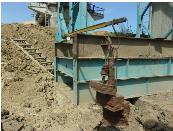
08.2016г. Работы выполняет ООО «ТЮС-КубаньМост». Железнодорожный мост на ПК169+50. Монтаж металлических конструкций консольных участков пролётных строений 1-6 (левая сторона). Контрольная тарировка динамометрического ключа КМШ-1400.
