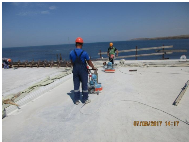
Пролет 12-16, ось В, Г, ППЧ (а/д мост). Подготовка ж/б поверхности ППЧ под гидроизоляцию. 08.2017
