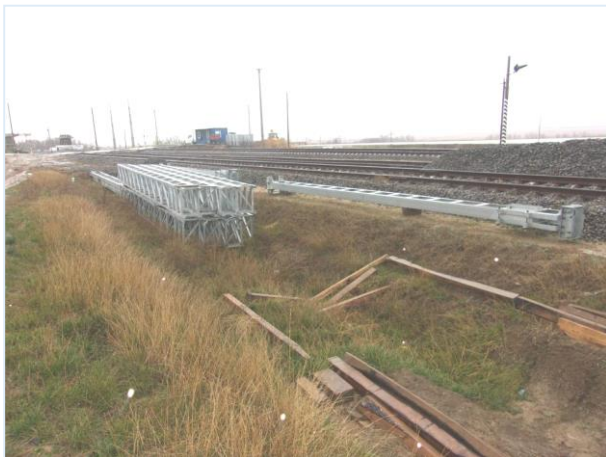
11.2016г. Работы ведёт ООО «ТЮС-МКС». Путьевое развитие, устройство ж. д. контактной сети на перегоне ст. Вышестеблиевская – обгонный пункт 22 км.
