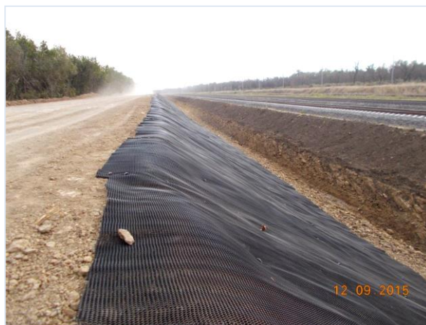
09.2015 Работы ведет ООО «ТЮС-МК-105». Укладка геоматов на откосы выемки ПК14+00-ПК18+30.
