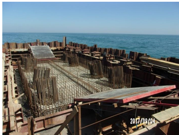
Опора № 91 (а/дорога). Устройство монолитного ростверка опоры. Армирование и установка опалубки монолитного ростверка опоры, I этап бетонирования. 09.2017
