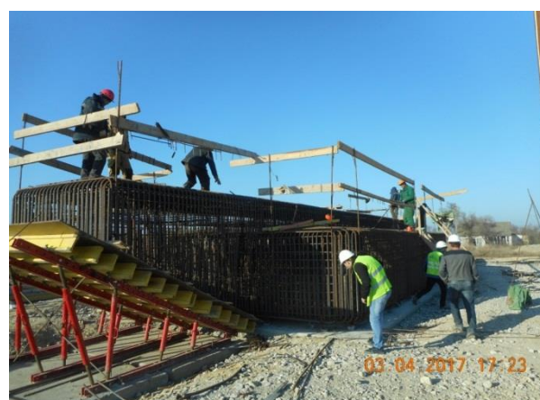
Опора №151(а/д мост). Инспекционный контроль устройства арматурного каркаса ростверк-ригеля перед установкой опалубки. 04.2017
