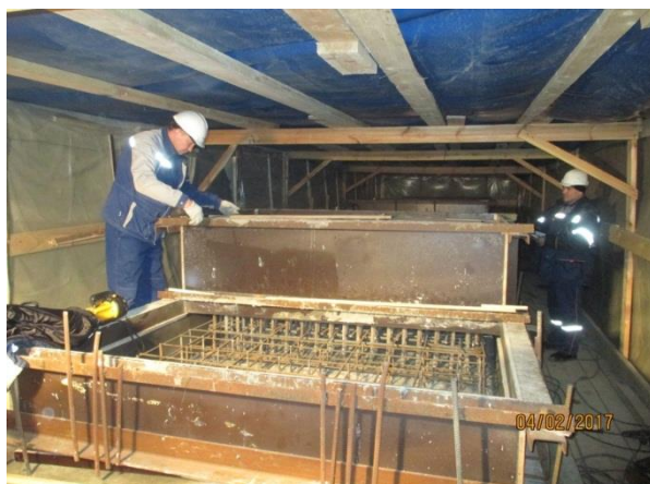
Опора №111 (а/д мост). Приемочный контроль армирования и устройства опалубки подферменных площадок ПМ-1, ПМ-2 и домкратных площадок ДМ1 02.2017
