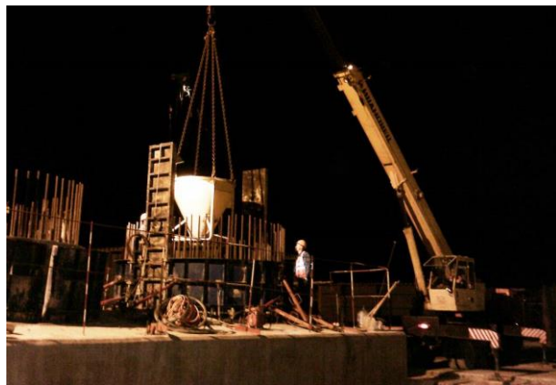
Опора № 200 (ж/д мост) Бетонирование стойки опоры, ось 3. 06.2017
