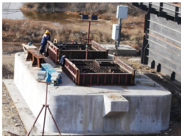
Опора № 170 (ж.д. мост). Устройство арматурного каркаса и опалубки подферменников опоры, оси А – Б. 12.2017
