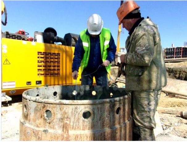
03.2017 г. Работы выполняет ООО «Зодчий». Железнодорожный мост на ПК277+22,5, сооружение свайного основания опоры №2 из БНС Ø 1200 мм с уширением Ø 2500 мм. Освидетельствование полости пробуренной скважины БНС.
