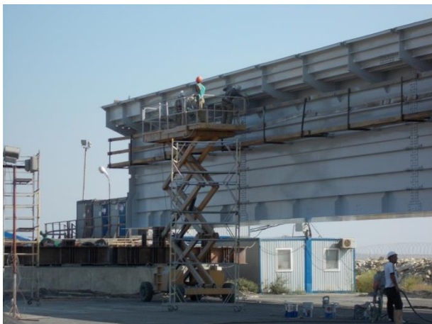
Пролётное строение в осях опор №№ 98-99 (ж/д мост). Устройство антикоррозионной защиты стальных конструкций пролётного строения в осях главных балок Б (фасад). Нанесение финишного слоя. 09.2018
