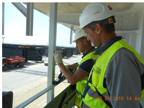
Пролетное строение в осях опор №155-№159 (а/д мост). Инспекционный контроль испытания на адгезию нанесенной антикоррозионной защиты на м/к пролетного строения в оси главной балки 1. 05.2018
