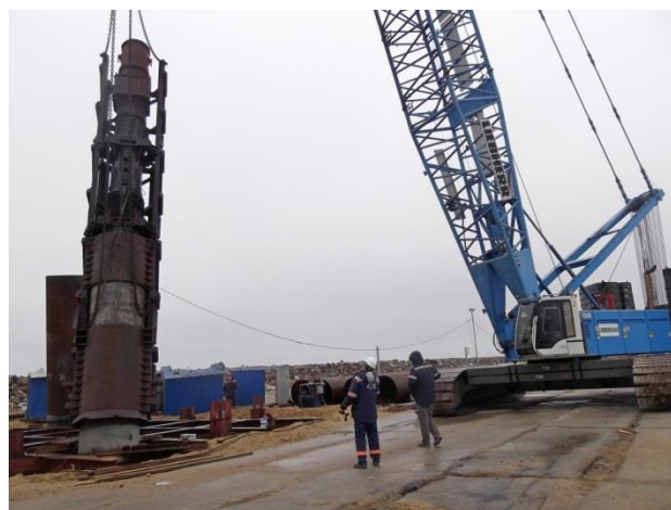
Опора №190 (ж/д мост). Свая № 9. Динамические испытания сваи Ø1420 мм. 01.2017
