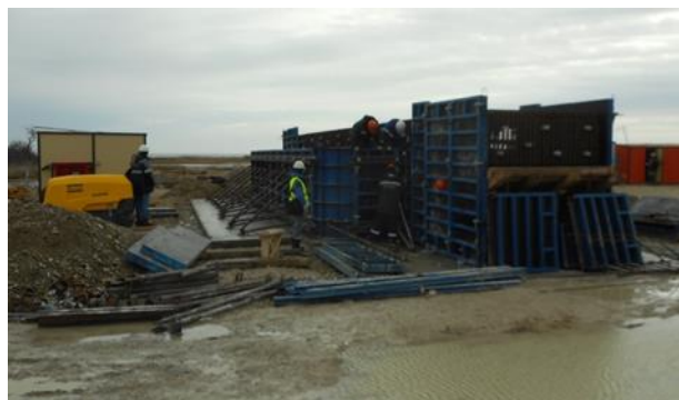
Опора №149 (а/д мост) Монтаж опалубки ростверк-ригеля. 01.2017
