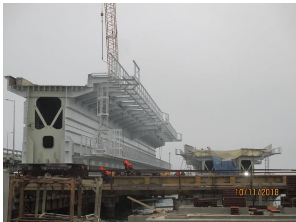
Пролётное строение в осях опор №№ 102-103 ж/д мост. Поперечная надвижка металлического пролетного строения в осях главных корыччатых балок А-Б. 11.2018
