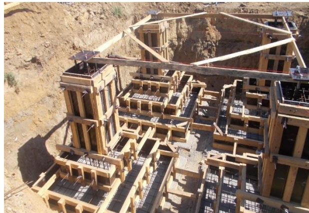
07.2018г. Работы выполняет ООО «СМУ ДС». Ст.Вышестеблиевская. Цифровая система поездной и станционной радиосвязи стандарт DMR. Поездная радиосвязь КВ-диапозона. Устройство арматурного каркаса и анкерных групп фундамента антенной опоры Н-30м.
