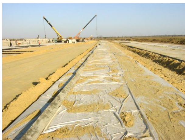
09.2015г. Работы ведет ООО «Агрооргтехстрой». Уход за бетоном площадок для складов металлических конструкций и инертных материалов.
