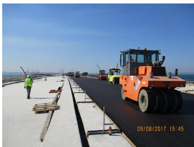
Устройство нижнего слоя покрытия А/Д моста опоры №179-183 Т=6см из плотного мелкозернистого полимер асфальтобетона Тип Б марка 1 на ПБВ 60 08.2017
