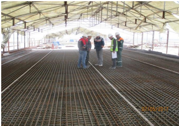
Пролетное строение в осях опор 75-79 (а/д мост). Ось В-Г. Приемочный контроль арматурного каркаса и установленной опалубки плиты проезжей части (захватка №7). 05.2017
