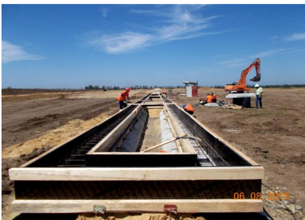
08.2015. Работы ведет ООО «Мегастрой». Устройство арматурного каркаса и установка опалубки монолитного ж/б пояса МП-1 на участке ПК8+34,7-ПК8+70,7.
