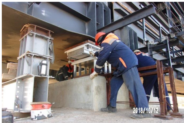
Пролётное строение в осях опор 153 – 154, опора № 154, ось Г. Устройство металлического пролётного строения (ж/д). Монтаж опорных частей. 10.2018
