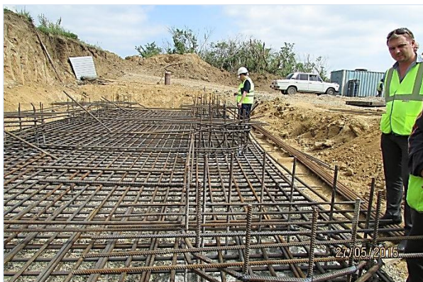
05.2015. Работы ведет ООО «ТЮС-КубаньМост». Армирование ростверка опоры №5 моста на ПК169+50. Хомуты поз.7 загнуты термическим способом.
