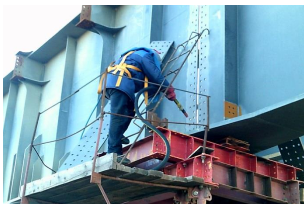
Пролёт 190 – 191, п.с. 12/3, ось 4 (а/д мост). Устройство сталежелезобетонного пролетного строения. Абразивоструйная очистка контактных поверхностей стыка главных балок 4ГБ16. 03.2017
