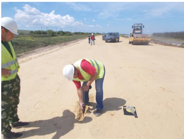
05.2016г. Работы ведет ООО «Мостовое бюро». Приемочный контроль работ ООО «СМП Трансстрой», устройство защитного слоя насыпи земляного полотна из дренирующего грунта, отсыпка, планировка, уплотнение 1 слоя. ПК175+00-ПК178+00.
