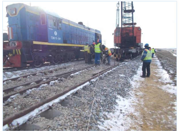
02.2017г. Работы ведет ООО «ТЮС-Путь». Выправка, подъемка стрелочного перевода №2 по II пути. Обгонный пункт ПК 209+00.
