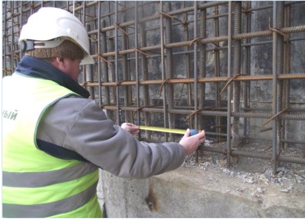
02.2016 г. Работы выполняет ООО «ТЮС-КубаньМост». Операционный контроль службы строительного контроля ООО «Мостовое бюро» армирования монолитного шкафного блока МШ-1 опоры 1.
