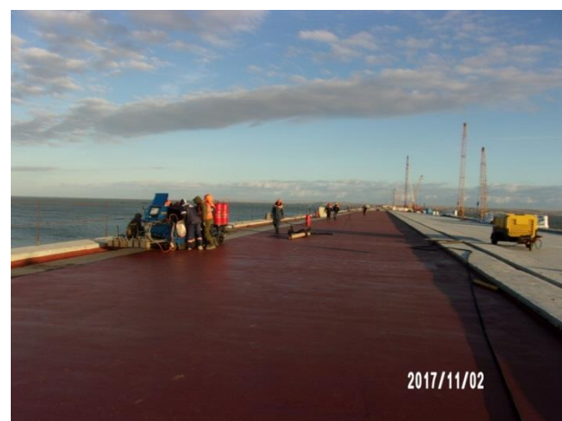
Пролётное строение в осях опор № 107-111 (а/д мост). Устройство гидроизоляции плиты проезжей части в осях главных балок 3-4, из наплавляемого рулонного материала Техноэластмост С. 11.2017
