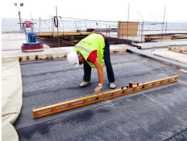
Пролёт 190 – 191, п.с. 12/3 оси 3-4. Устройство сталежелезобетонного пролётно строения (а/д мост). Инспекционный контроль ровности поверхности плиты проезжей части перед укладкой асфальтобетонной смеси. 07.2017
