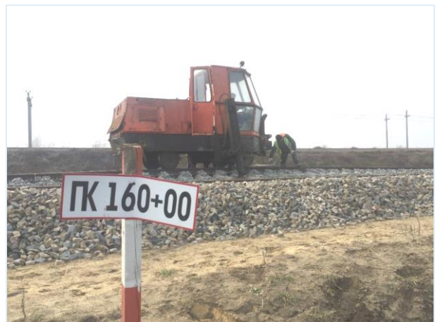
03.2017г. Работы ведет ООО ТЮС-Путь». Операционный контроль выправки, подъемки I пути машиной ПРМ ПК 155+00- ПК164+00.
