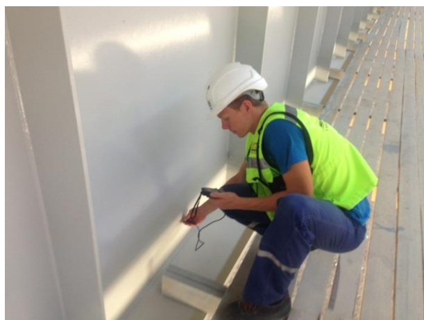
Пролет 126-127 (а/д мост). Приемочный контроль нанесения финишного слоя АКЗ на наружные поверхности по осям 2,3. 07.2017
