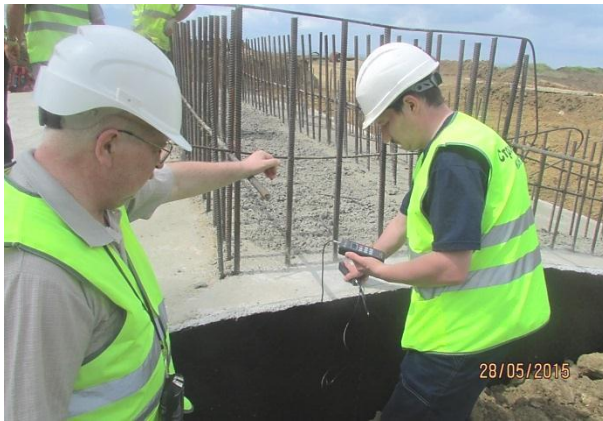
05.2015. Работы ведет ООО «Мостовое бюро». Проведение замеров защитного слоя бетона на ростверке опоры №1 железнодорожного путепровода на ПК237+76 прибором «Поиск-2,5».
