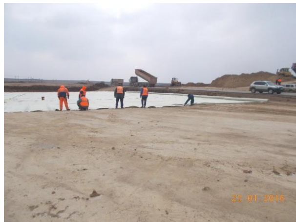
01.2016г. Работы ведет ООО «Радон». Укладка геотекстиля 1-ой грунтовой обоймы насыпи земляного полотна ПК 246+80-ПК247+75.
