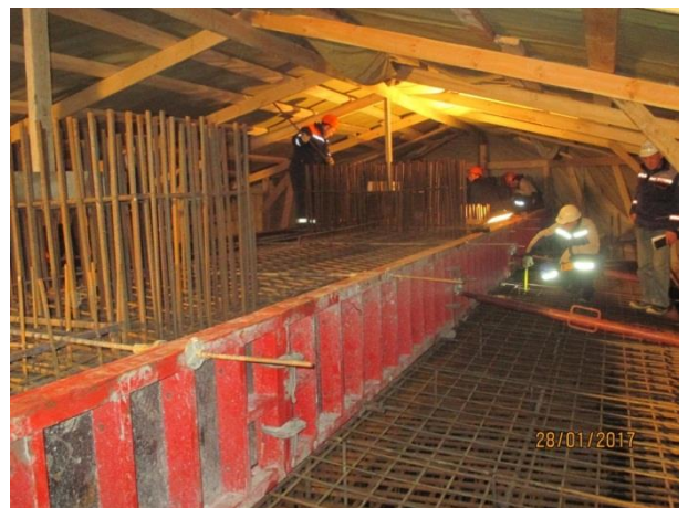
Опора №147 (а/д мост). Приемочный контроль арматурного каркаса и установленной опалубки ростверка и тела опоры. 01.2017
