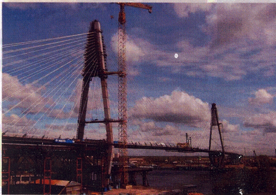
Мост Большой Обуховский через р. Неву
