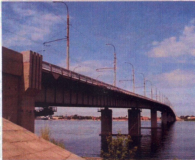
Мост через р. Волгу в Астрахани
