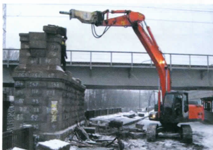
Рис. 1. Демонтаж существовавших конструкций и временной опоры
