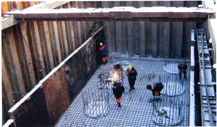
Рис. 6. Устройство фундаментов
