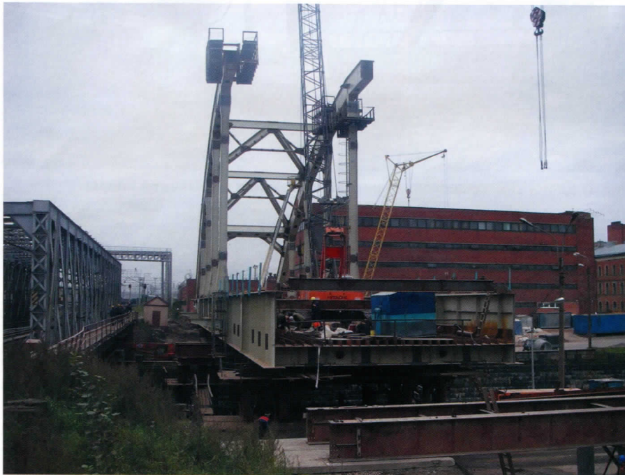
Рис. 4. Монтаж элементов арки
