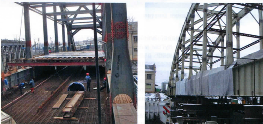
Рис. 5. Подготовка к бетонированию плиты
