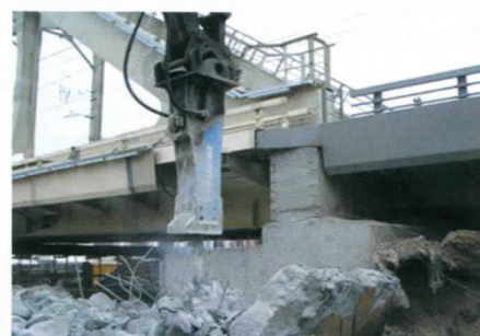
Рис. 1. Демонтаж существовавших конструкций и временной опоры
