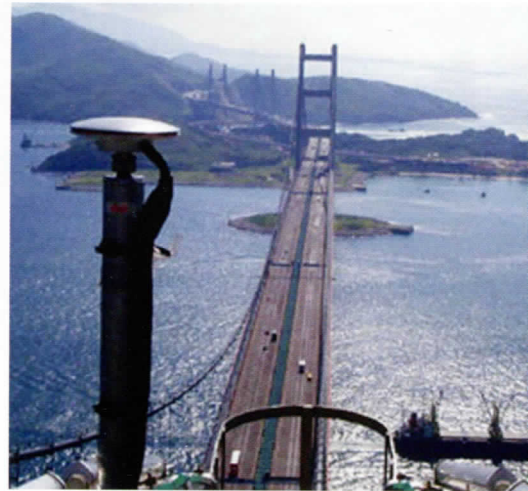
Рис. 1. GPS-приемник на вершине мостовой башни моста Тсинг Ма
