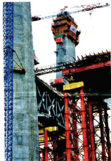
Два новых лифта смонтированы на внутренней стороне каждой «ноги» пилона.
