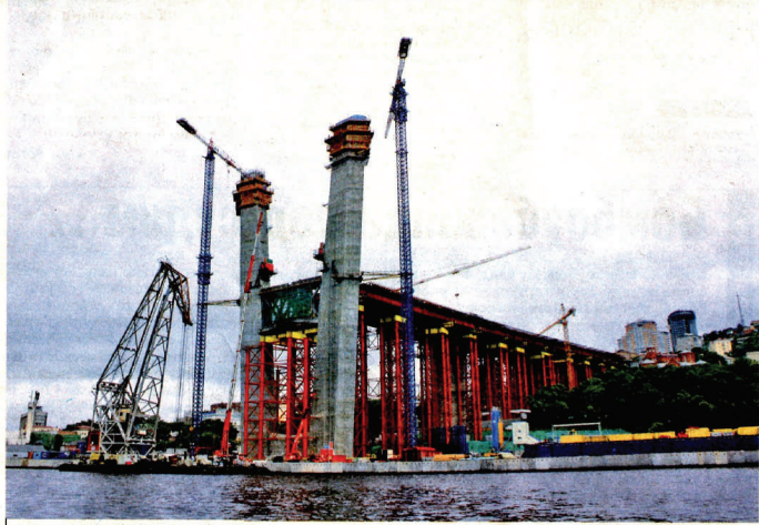
Северный пилон моста достиг отметки 110 метров.
