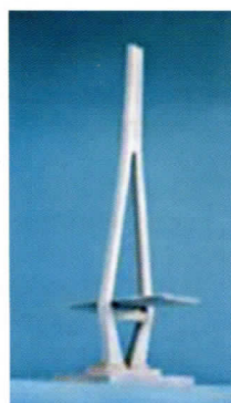
Перевернутая Y-форма пилона (основной вариант)
